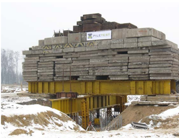
Rys. 1. Stanowisko do próbného obciążenia statycznego.
