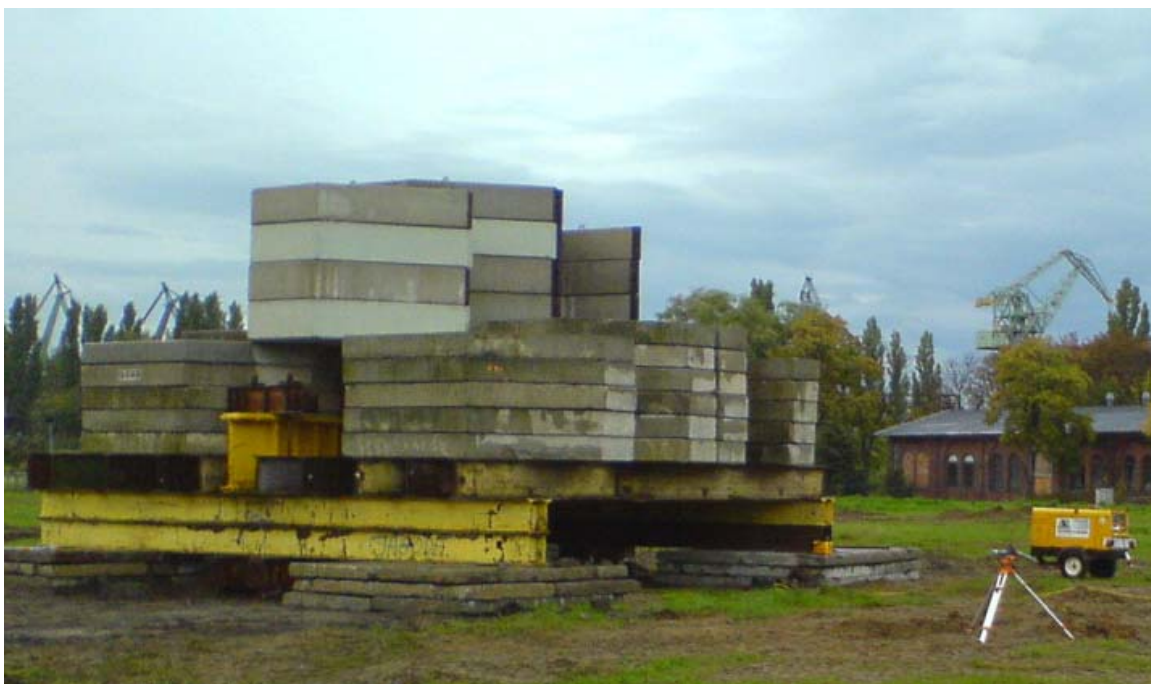
Rys. 2. Stanowisko do próbnego obciążenia pala VDP
