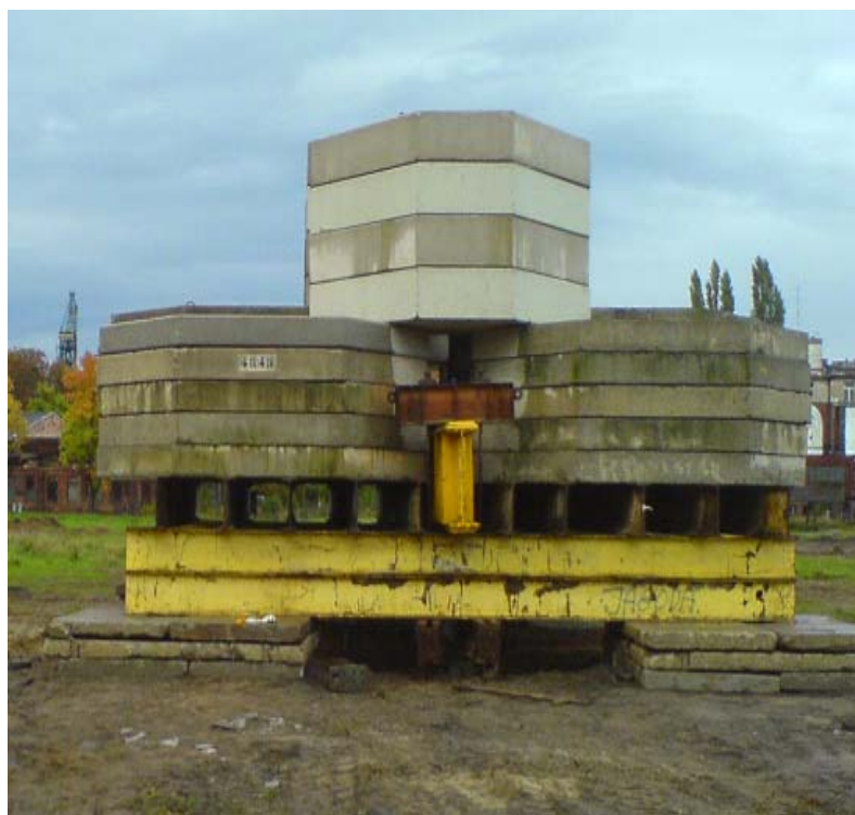
Rys. 1. Stanowisko do próbnego obciążenia statycznego pali VDP
