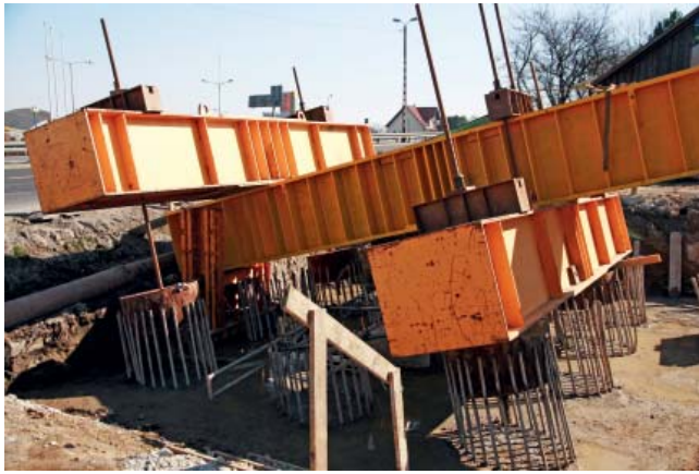
Fot. 6. Próbné obciążenie pali ukośnych
