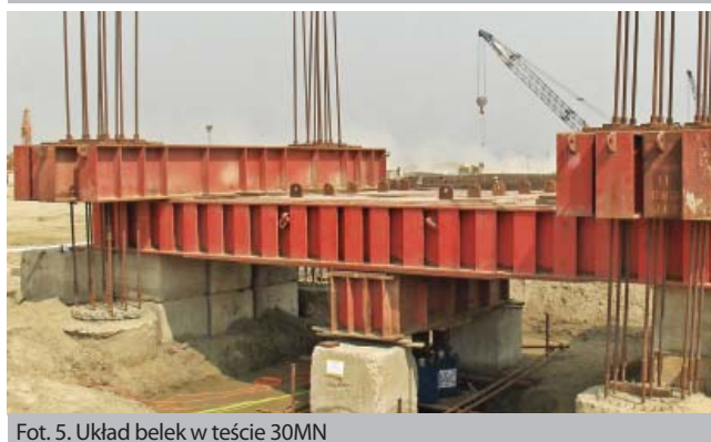
Fot. 5. Układ belek w teście 30MN
